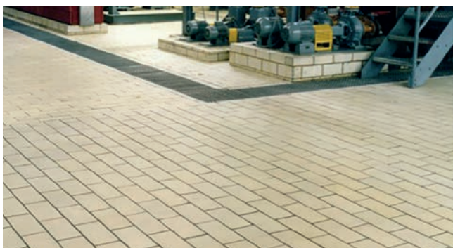
Kombinationsbelag bestehend aus Dichtschiicht und keramischen Platten
