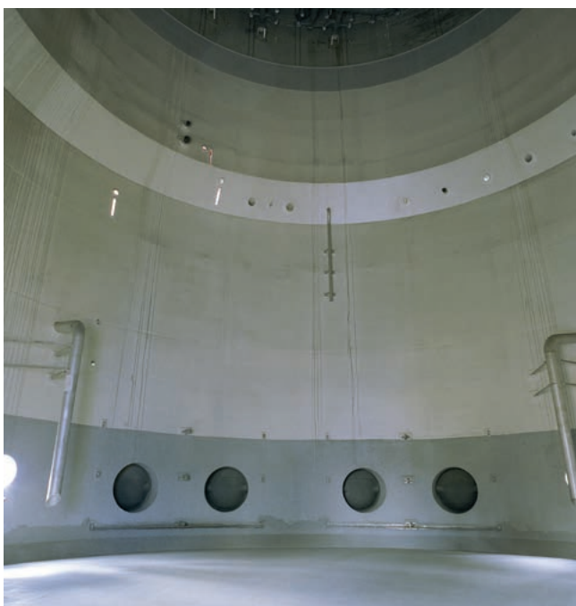
Mit COROFLAKE 24 und LINING 65 W beschichteter Absorber
