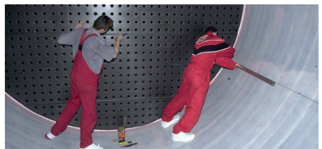
Gummierung eines Filterbehälters
