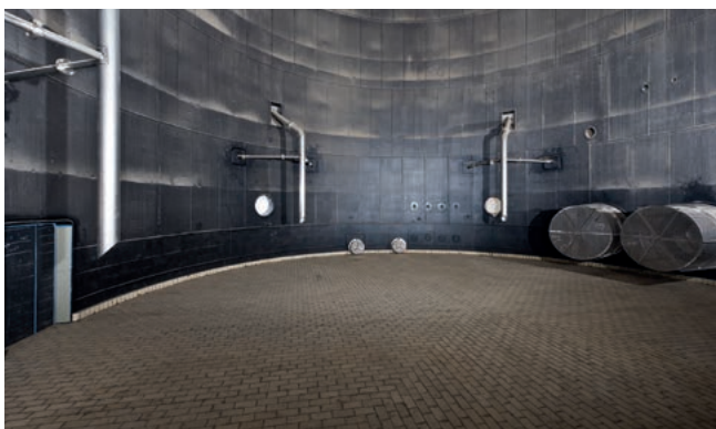
Absorberboden mit CHEMOLINE 4 B gummiert und zusätzlicher Ausmauerung mit CHEMOKITT FU 1310
