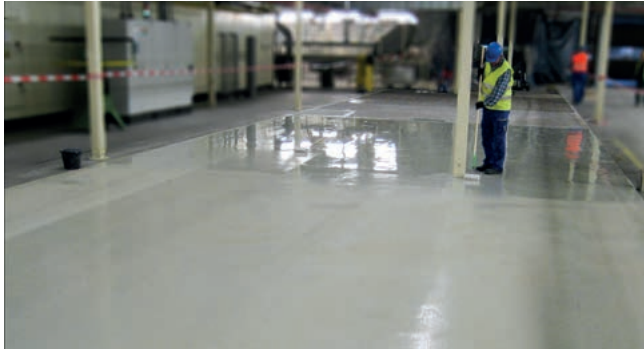
ESKANOL EF Bodenbeschichtung mit rutschfester Deckschicht
