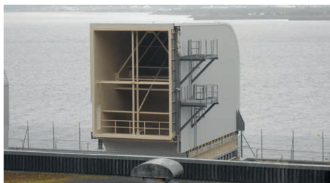
Mit COROFLAKE 24 beschichteter Reingaskanal
