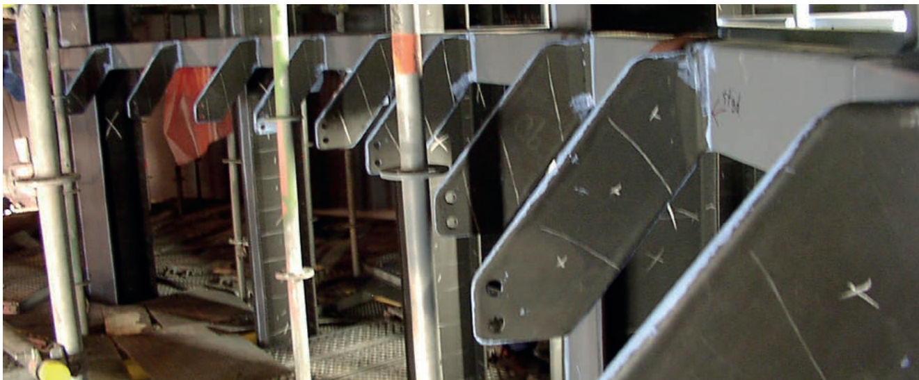
Gummierte Halterungen in einem Absorber
